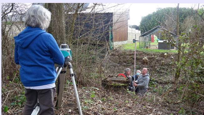
Il restait à mieux connaître le relief. Des travaux topographiques préliminaires ont été réalisés par une équipe d'adhérents, grâce au matériel de Philippe Garreau : niveau à laser tournant et mire appropriée, mètre laser,...etc. Ces relevés ont permis de dessiner deux profils selon des axes sensiblement Sud-Nord et Ouest-Est. L'article ci-après fait la brève synthèse des résultats obtenus par ces investigations de terrain complétant les autres sources relatives à ce château médiéval.
