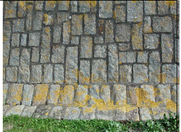
Détail d'agencement des pierres (pavés de la rue St Guillaume de St Brieuc)
