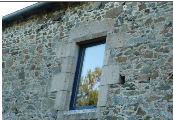
Détail d'un linteau
