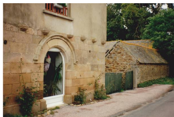
Pignon du bâtiment principal
