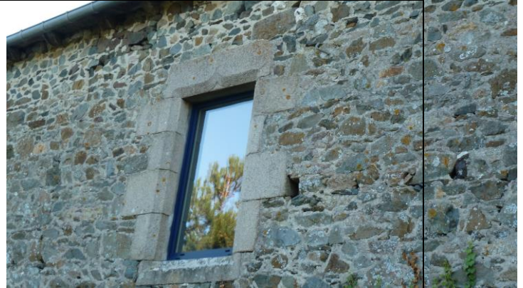
Linteau de La Caquinerie
