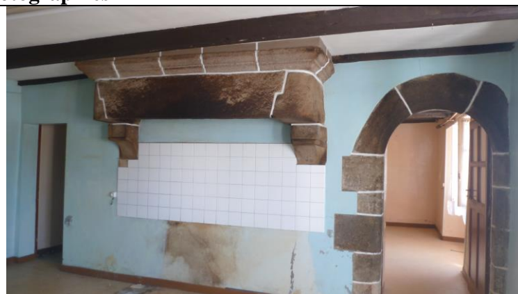
Vestiges du manoir : cheminée et porte intérieure
